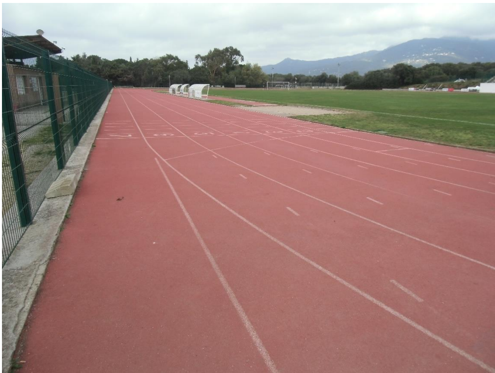
Vue terrain côté OUEST
